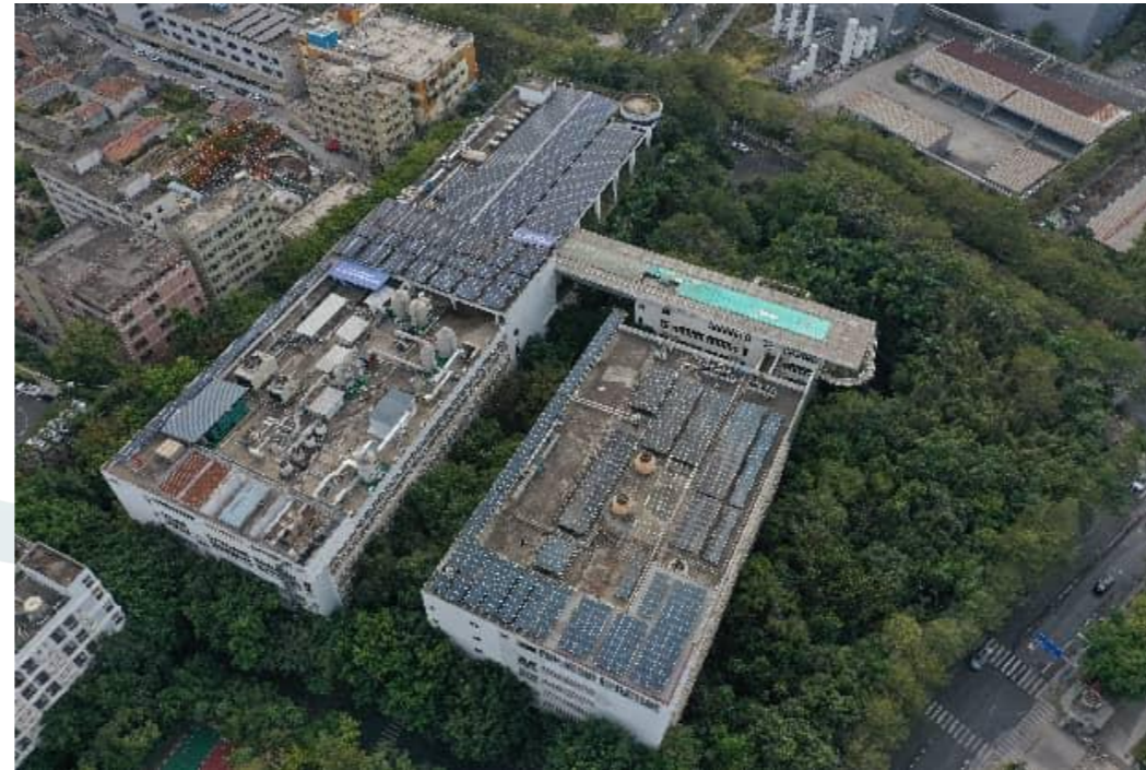
楼顶铺设屋顶光伏 (0.62 兆瓦)
